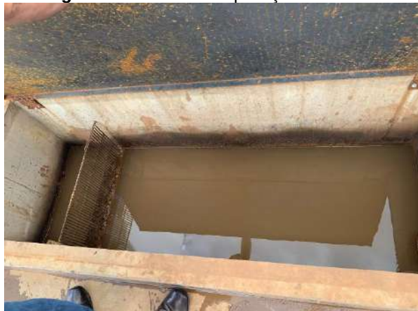
Figura 14: Caixa de separação de barro.
