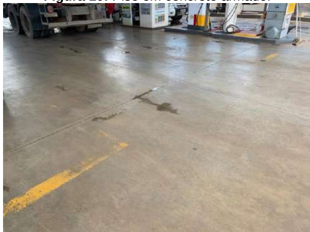
Figura 10: Piso em concreto armado.
