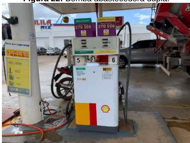
Figura 22: Bomba abastecedora dupla.
