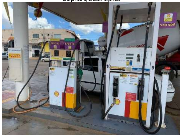
Figura 20: Bombas abastecedoras dupla/quádrupla.
