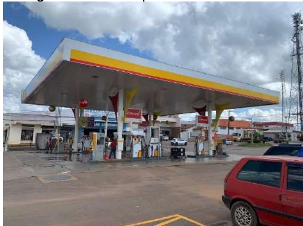
Figura 02: Área da pista de abastecimento.
