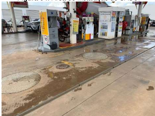
Figura 04: Área de Instalação do SASC.
