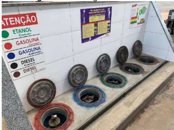
Figura 08: Descargas à distância.
