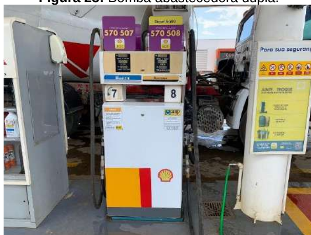
Figura 23: Bomba abastecedora dupla.
