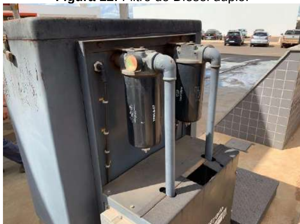
Figura 12: Filtro de Diesel duplo.
